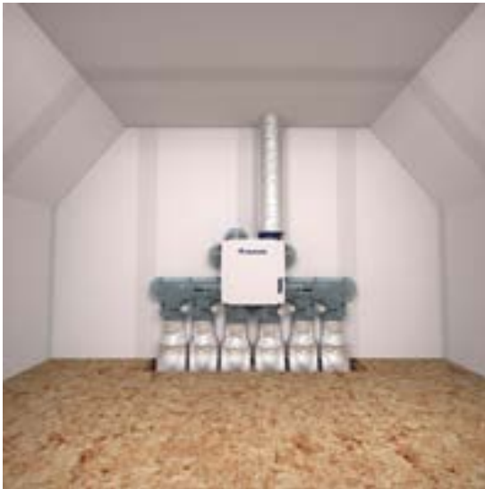
Meerdere luchtkanalen naar beneden
